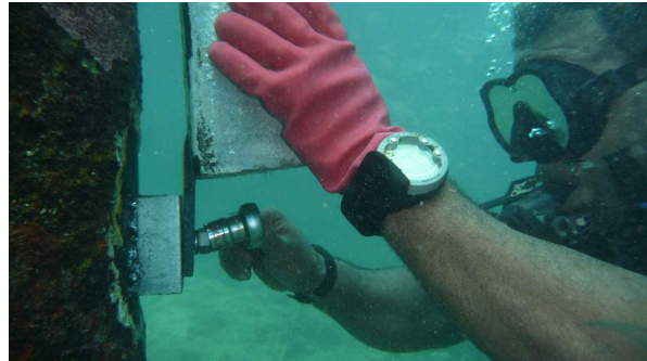
Figure 6 : Boulonnage d'une anode - Wharf de Léava à Futuna - Archipel de Wallis et Futuna
