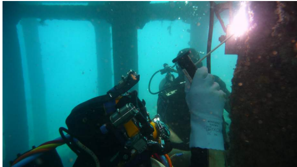
Figure 5 : Soudage en pleine eau des cavaliers supports - Wharf de Léava à Futuna - Archipel de Wallis et Futuna
