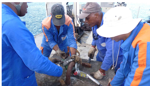
Figure 13 : Manillage sur la cigale d'un câble de mouillage tendu
