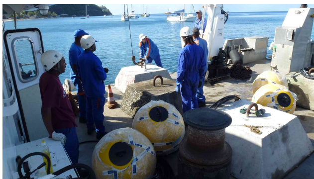
Figure 14 : Débordement d'un corps-mort avec la grue
