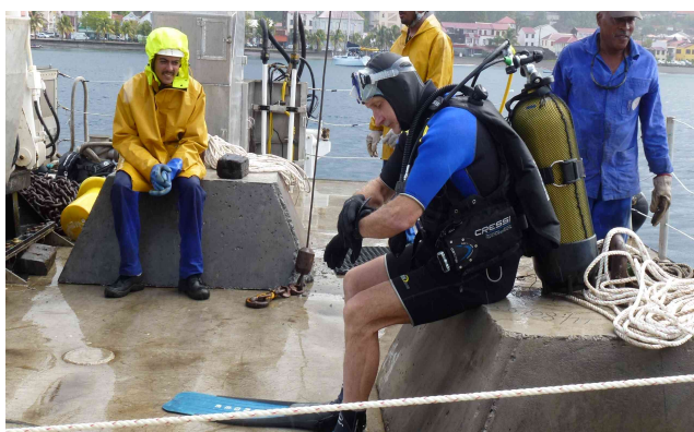
Figure 7 : Mise en place des corps mort et des mouillages tendus avec flotteurs subsurfaces - Vérification des points d'immersion
