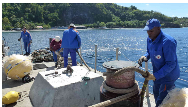
Figure 15 : Descente d'un corps mort à l'aide du cabestan
