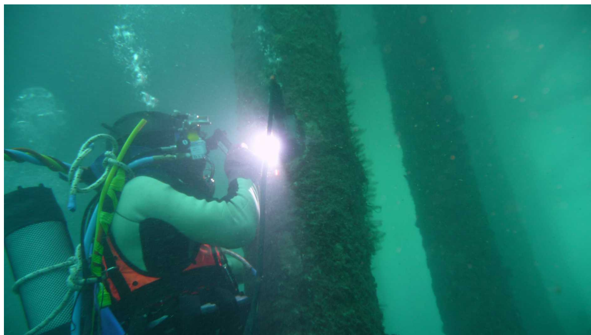
Soudage en pleine eau - AMOE - wharf de Léava à Futuna - Wallis et Futuna - Pacifique Sud
