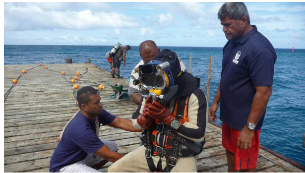
Figure 8 : Préparation de l'intervention - Wharf de Futuna
