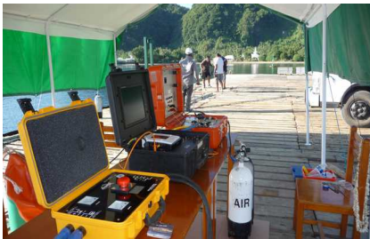
Figure 1 : Coffret coupe circuit avec ampèremètre et voltmètre - Wharf de Futuna
