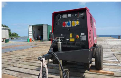
Figure 5 : Poste à souder diesel autonome - Wharf de Futuna
