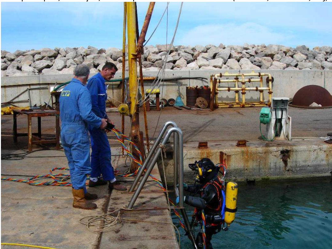
INPP Marseille/BV Mise à l'eau - Stage soudage en pleine eau
