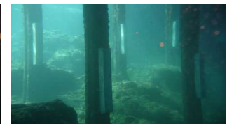
Figure 6 : Anodes en place : Durée de vie de 15 ans minimum
