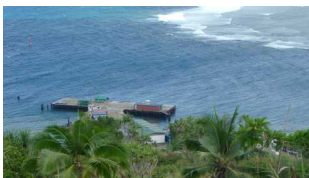
Figure 3 : Vue du wharf : 180 pieux-tubes
