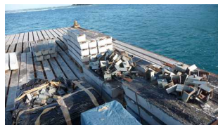
13 tonnes d'anodes sacrificielles Al/Zn/In à fixer
